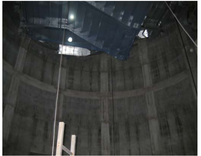
エレベータと非常階段が設置される心柱の内部は、人の目にふれるため、きれいなコンクリート肌が求められた。同社の剥離性の高いフッ素樹脂コーティングが活かされる。
