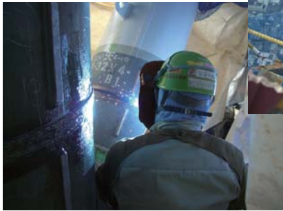
難しい横向き姿勢の多かった作業現場。
